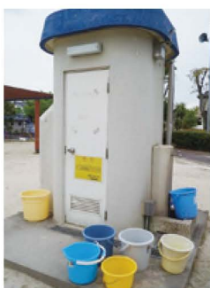
学校のグラウンドにある 屋外トイレ
