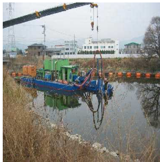
正法寺川の浚渫状況
