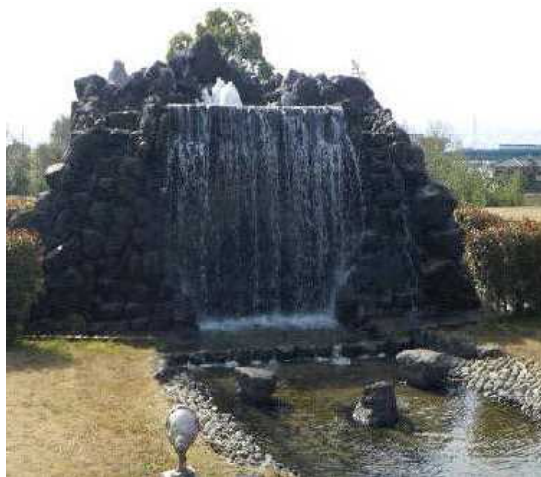
浄化用水ポンプ
