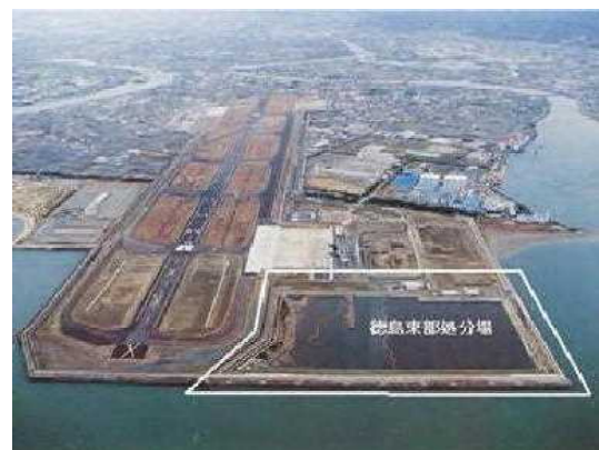
徳島東部処分場（管理型最終処分場）
