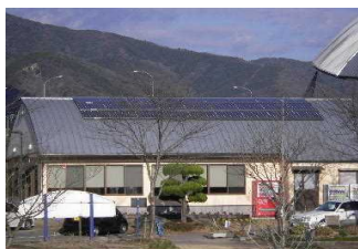
太陽光パネル設置施設
