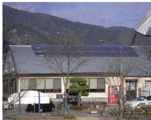
太陽光パネル設置施設
