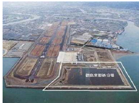
徳島東部処分場（管理型最終処分場）
