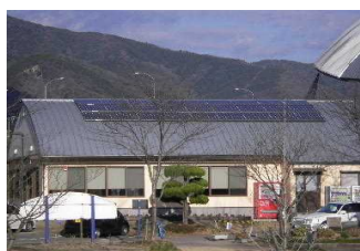
太陽光パネル設置施設
