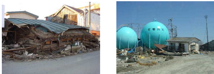
東日本大震災被災状況(宮城県石巻市)
