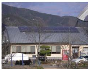
太陽光パネル設置施設
