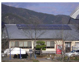
太陽光パネル設置施設
